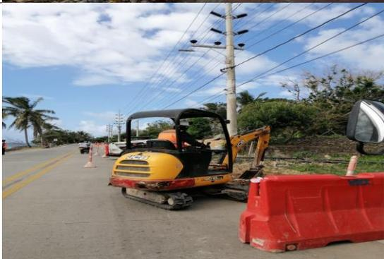
**Utilización de maquinaria pesada para extracción de cobertura vegetal:** La maquinaria pesada es utilizada en zonas donde predomina el concreto y/o se requiere hacer excavaciones más profundas para la instalación de tubería. Es una actividad no rutinaria puesto que no se utiliza con frecuencia esta maquinaria.
